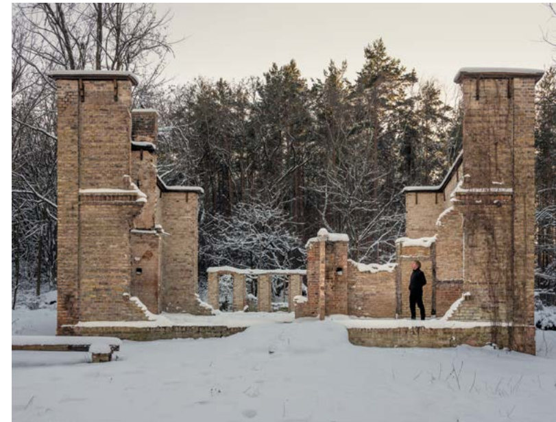
Die nach dem Brand geretteten Mauern des Zechenhauses am ehemaligen Tagebau Waldeck
